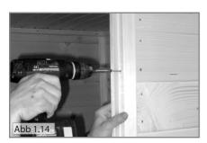
10. Stellen Sie jetzt die Glastüre mit dem Rahmen in die Öffnung. Sie können die Aufgehrichtung der Türe von links nach rechts ändern, indem Sie den Glastürrahmen um 180° drehen. Der Rahmen muss mit der Seite bündig sein und darf nicht vorstehen. (Schrauben 4x70 - Abb.1.14)
