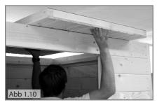
7. Sind alle vier Leisten montiert, können Sie die beiden Dachelemente auf die Leisten legen. (Abb.1.10 + Abb.1.11) Danach verschrauben Sie die Dachteile von oben. (Schrauben 5x80)
