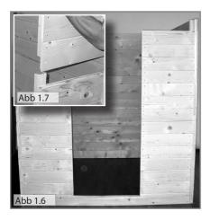
4. Stellen Sie die hintere und die linke Seite (Teil II) auf die unteren Seiten und verschrauben sie diese seitlich miteinander. (Schrauben 5x80) Achten Sie darauf, dass innen keine Schrauben sichtbar sind. Verfahren Sie mit der rechten und den vorderen Seiten genauso.(Abb.1.7)
