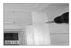
14. Befestigen Sie jetzt die inneren und äußeren Abdeckleisten an dem Türstock und an der Türseite. (Schrauben 3x40) Der Abstand zum Türrahmen beträgt ca.12 mm auf allen Seiten. (Abb.1.19)
