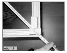
3. Kontrollieren Sie, ob die Saunakabine im rechten Winkel steht, indem Sie diagonal die Länge auf beiden Seiten messen. (Abb.1.5)
