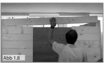
5. Legen Sie nun die oberste Blockbohle auf die vordere Seite und verschrauben diese mit den Seiten. (Schrauben 3x40 - Abb.1.8)
